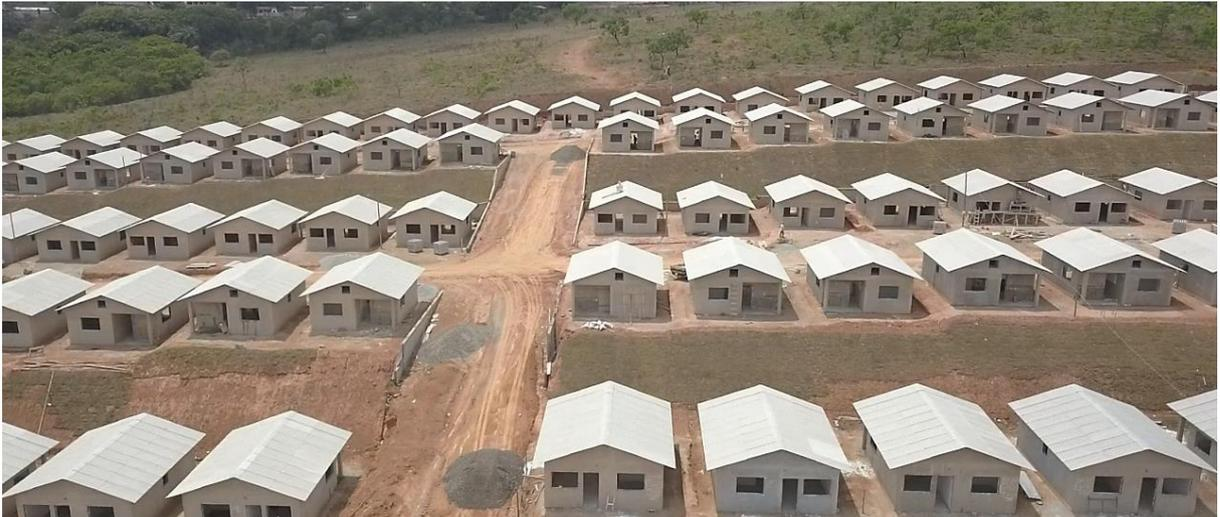
**FIGURA 23:** Período de obras em setembro de 2020, percebe-se a repetição da tipologia e o desnível do terreno resolvido com a construção de taludes em todas as quadras. **FONTE:** Rodrigo Araújo, 2020.
