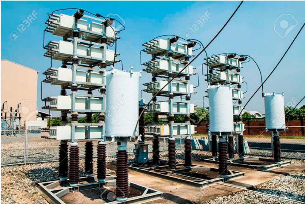
Figura 6: Banco de capacitores
