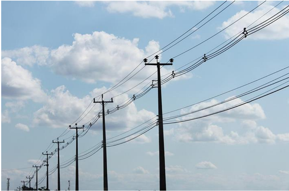
Figura 2: Linha de distribuição
