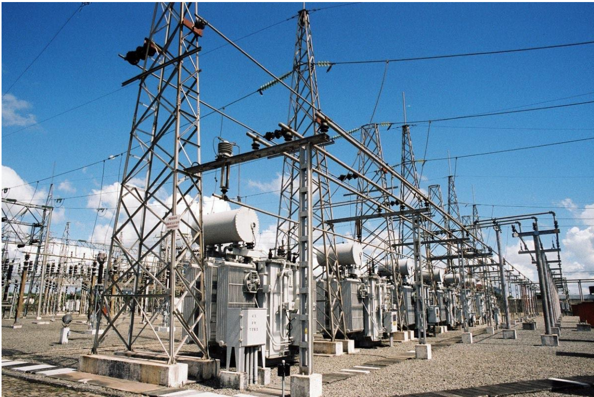
Figura 5: Subestação de distribuição
