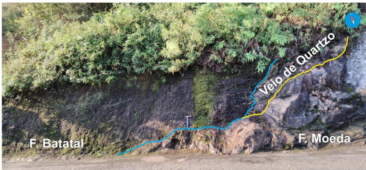
**Figura 3.45:** Contato litológico do filito da Fm. Batatal com o quartzito da Fm. Moeda
