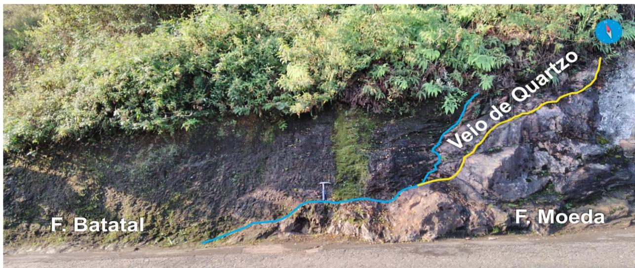
a) corte de estrada expondo o contato entre as formações Batatal e Moeda, com diferentes comportamentos geotécnicos;
