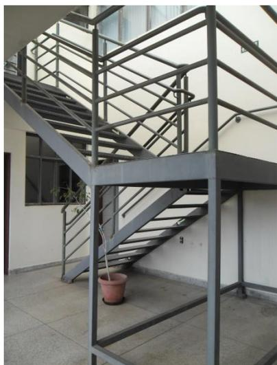
Figura 67 - escada inserida posterior a construção para o acesso da parte do edifício que foi ampliada. Fonte: Produzida pela Autora. Data: 03/11/2018.
