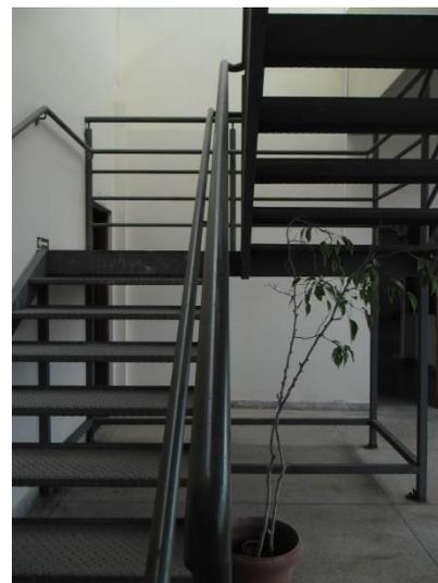
Figura 68 - escada inserida posterior a construção para o acesso da parte do edifício que foi ampliada. Fonte: Produzida pela Autora. Data: 03/11/2018.
