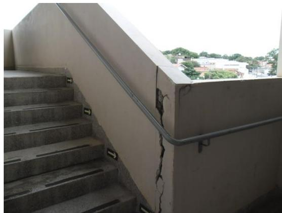
Figura 66 - Escada de circulação comum vertical apresentam rachaduras. Fonte: Produzida pela Autora. Data: 03/11/2018.
