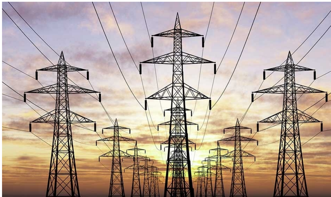
Figura 4 – Linha de Transmissão. Fonte: (PMA, 2018)
