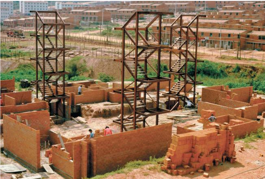
Figura 30 - Escada em estrutura metálica independente
