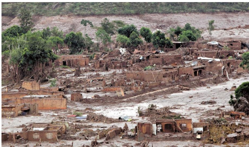
Figura 3: Bento Rodrigues após o desastre de Fundão
