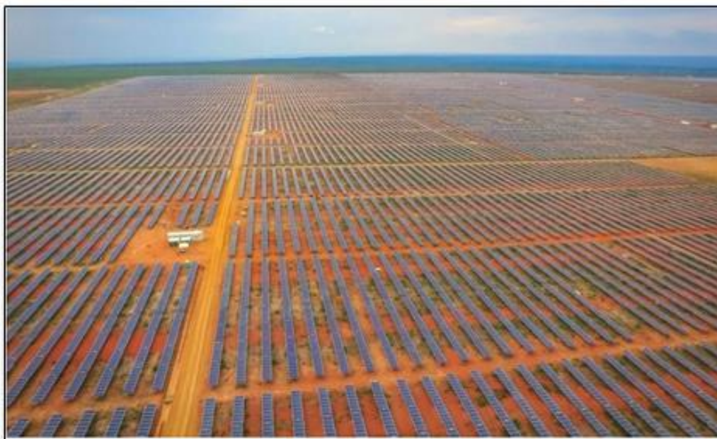
Figura 17: Parque Solar Horizonte, localizado em Tabocas do Brejo Velho, BA.
