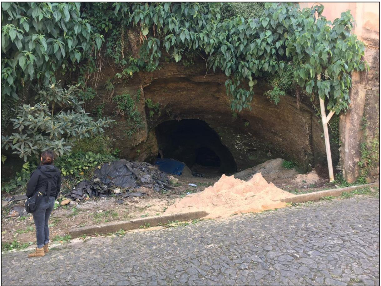
Figura 5.8 - Cavidade de itabirito localizada na rua Santa Rita, com edificação em uso ao lado.
