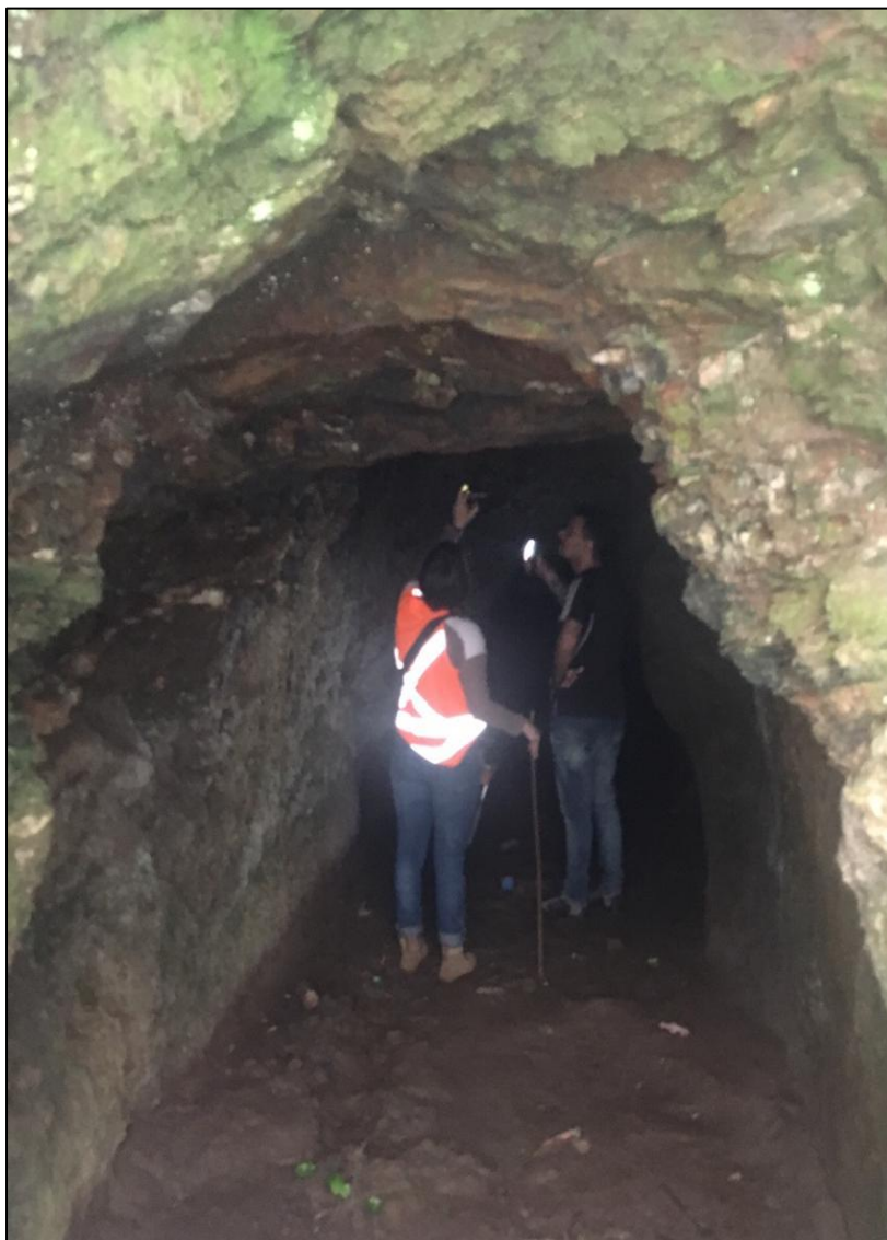
Figura 5.20 - Abertura da cavidade existente no litotipo quartzo-sericita xisto. Observa-se forte alteração nas paredes da escavação.
