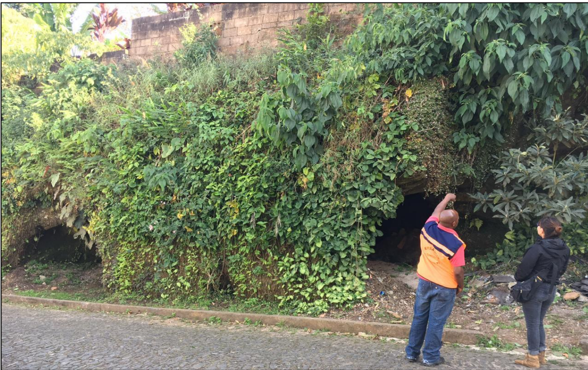
Figura 5.9 - Cavidades localizadas na rua Santa Rita, com edificações em uso 2m acima.
