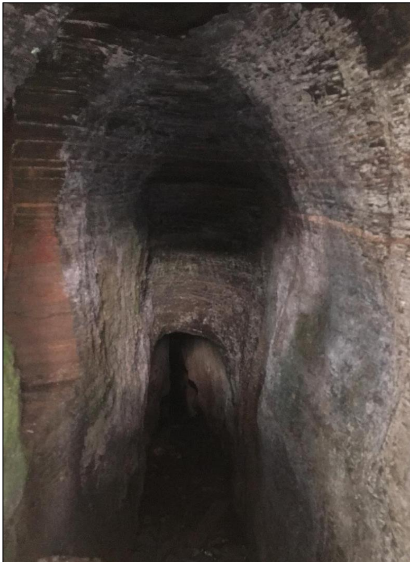
Figura 5.15 - Mina do Padre Faria, cavidade de itabirito localizada na rua Santa Rita.
