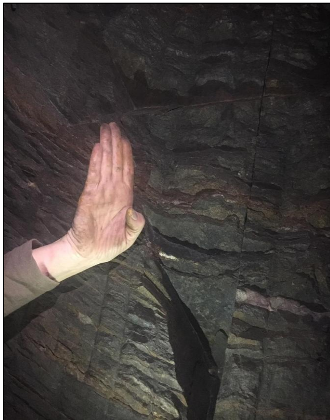
Figura 5.18 - Encontro de duas famílias de fraturas, formando estrutura em cunha, no itabirito.
