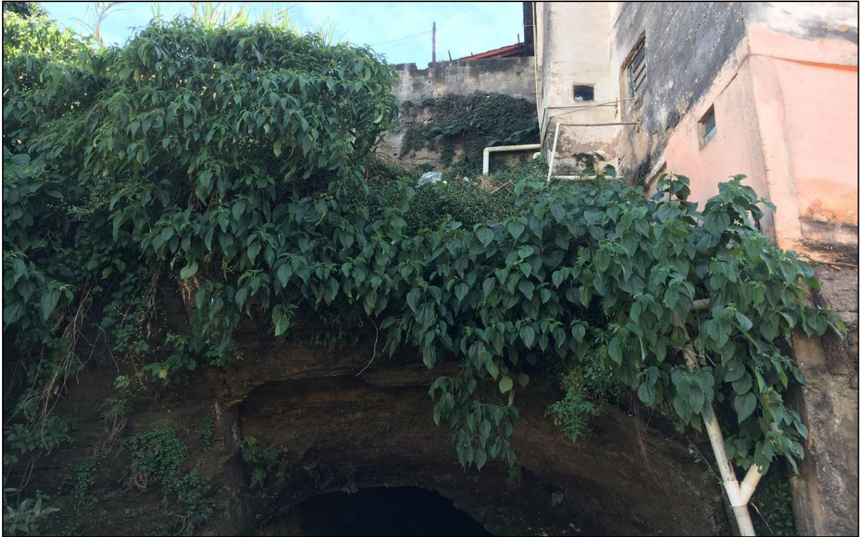
Figura 5.11 - Edificação com três pavimentos, construída ao lado de uma cavidade.
