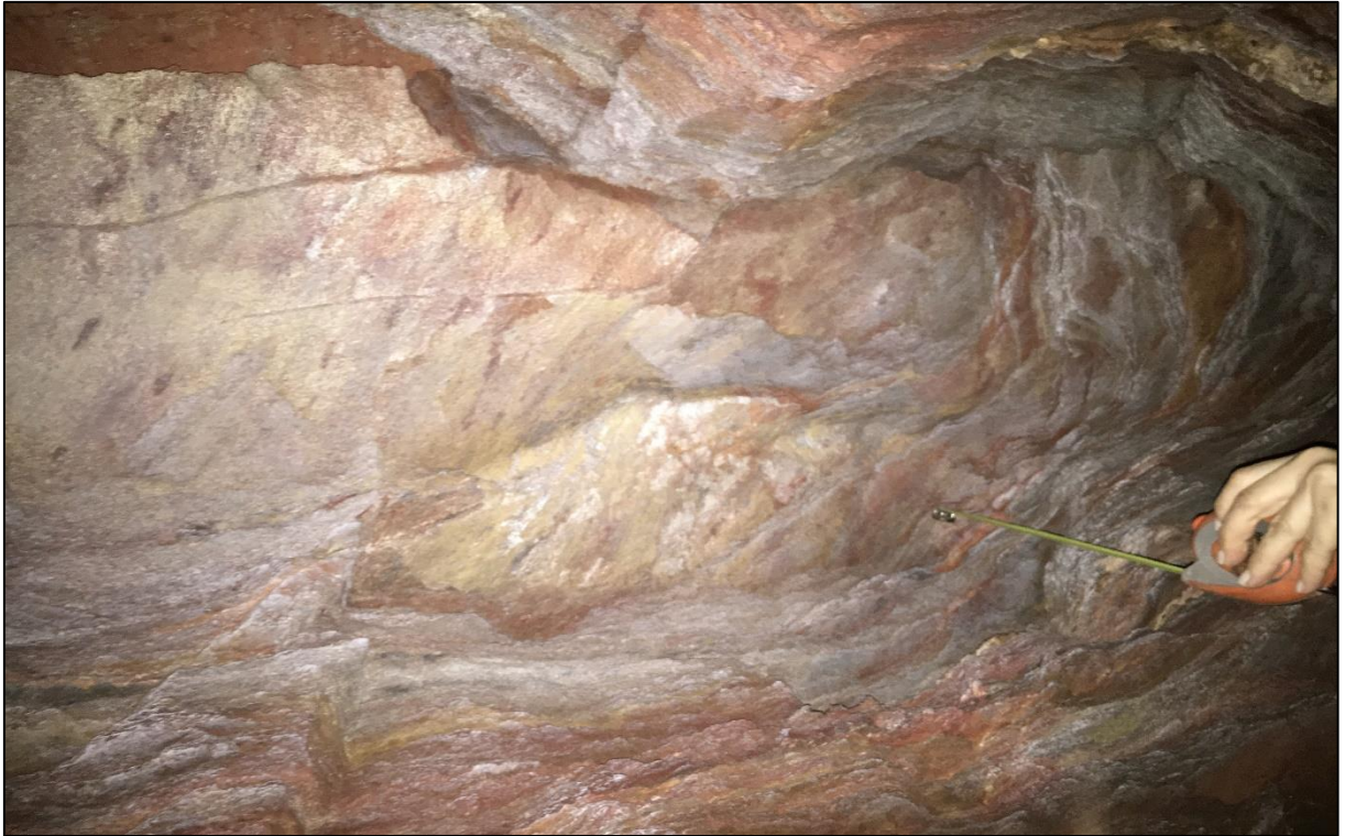
Figura 5.24 - Deslocamento observado no teto da cavidade composta por quartzo-sericita xisto.
