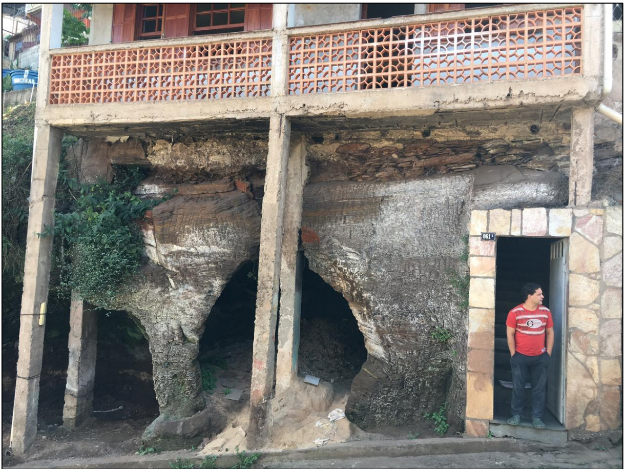
Figura 5.5 - Cavidades localizadas na rua Santa Rita, com edificação em uso sobre a escavação.
