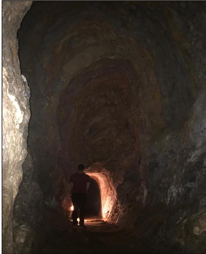
Figura 5.27 - Galeria de quartzo-sericita xisto, porção final da cavidade, com deslocamento do teto.
