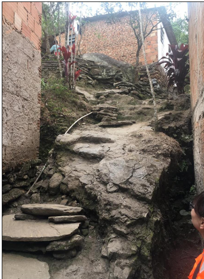
Figura 5.19 - Acesso para a cavidade abaixo da escada existente na área. Ponto localizado no bairro São Francisco.
