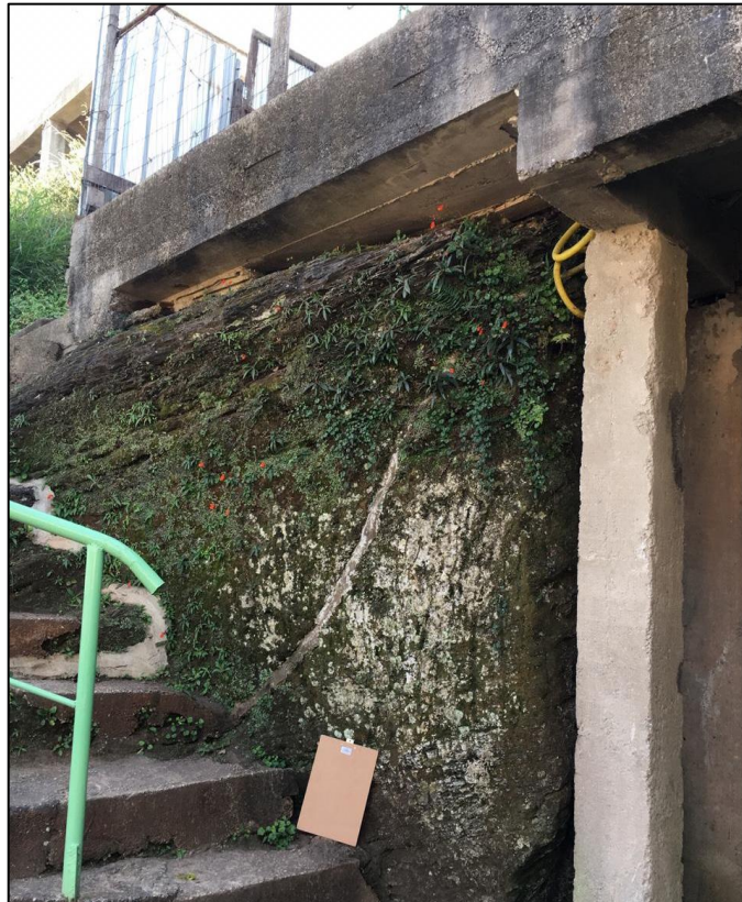
Figura 5.12 - Fratura preenchida por cimento, próximo às cavidades descritas.
