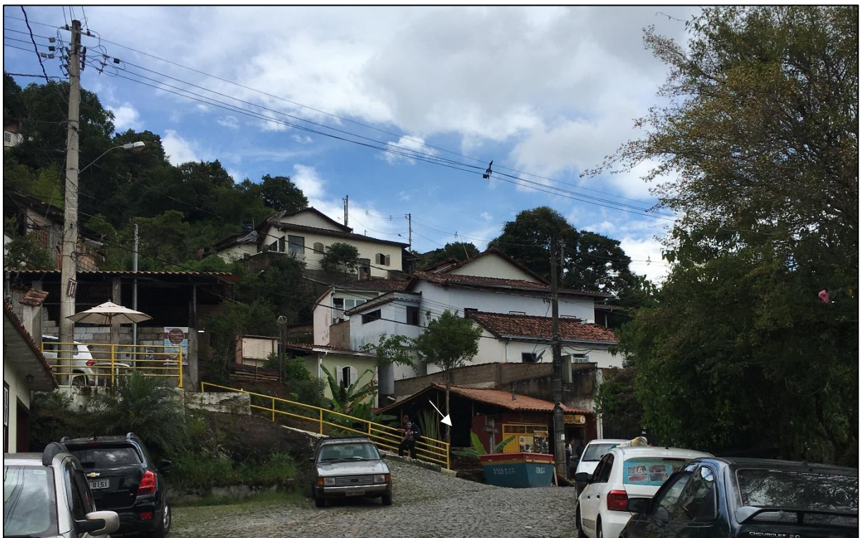
Figura 5.34 - Edificações existentes sobre cavidade turística do bairro Antônio Dias. A seta mostra a entrada para a visitação da Mina do Chico Rei.
