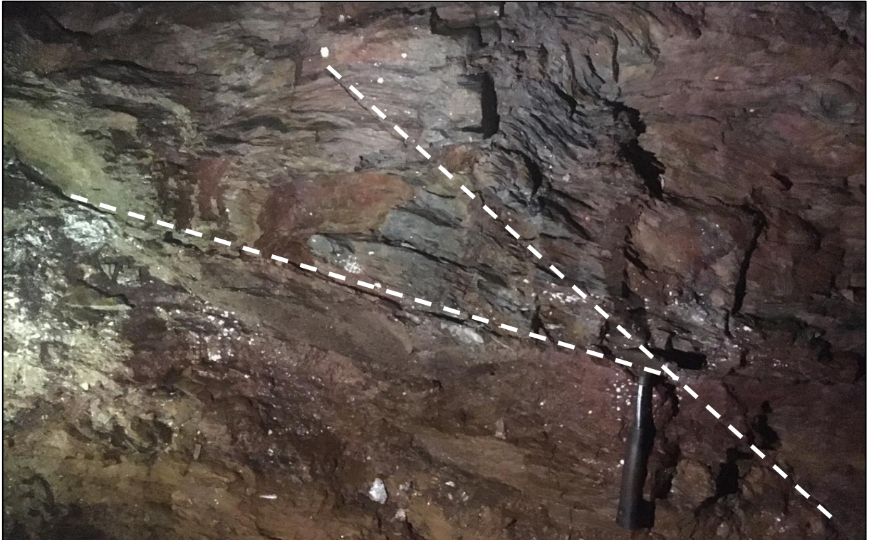
Figura 5.21 - Planos de fraturas existentes na cavidade, formando estruturas em cunha.
