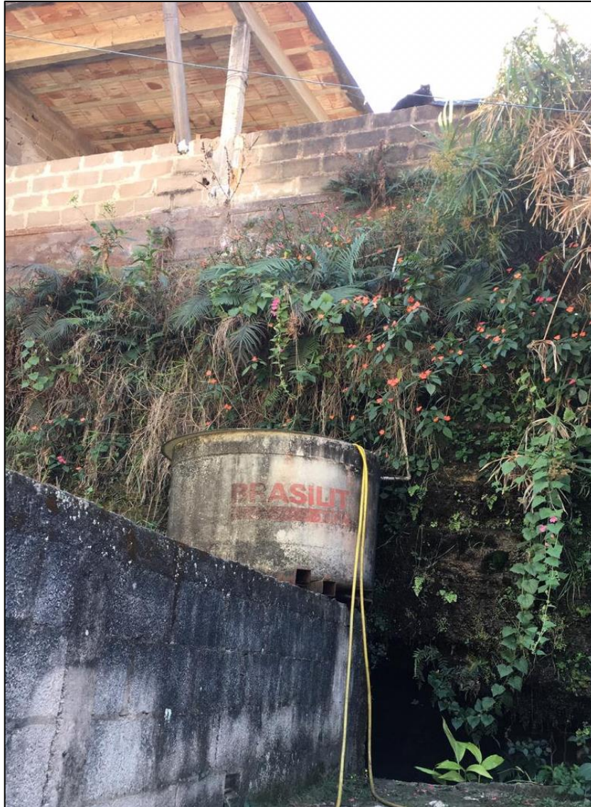
Figura 5.14 - Identificação de edificações acima e ao lado da cavidade.
