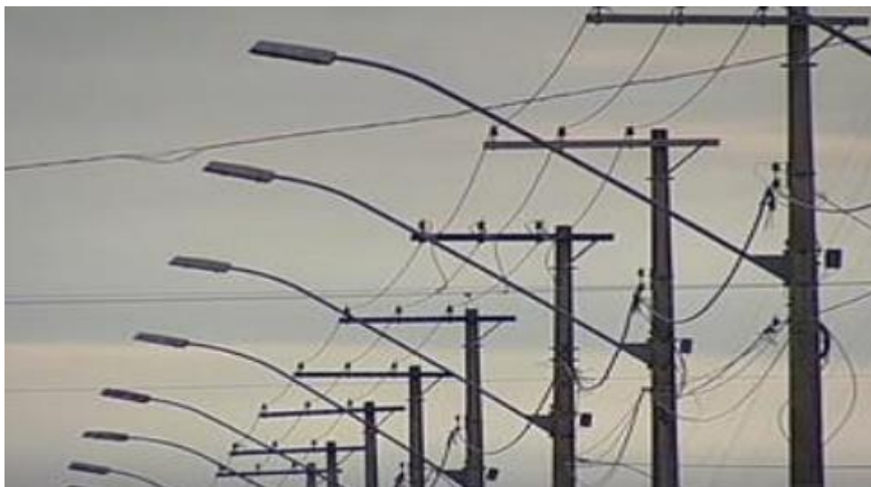
Figura 2: Rede aérea de distribuição de energia elétrica.
