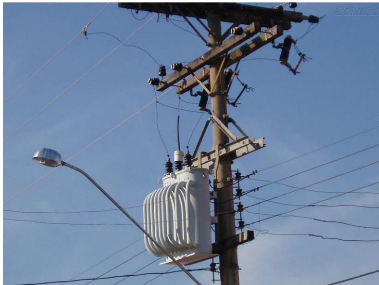
Figura 4: Transformador utilizado na distribuição de energia
