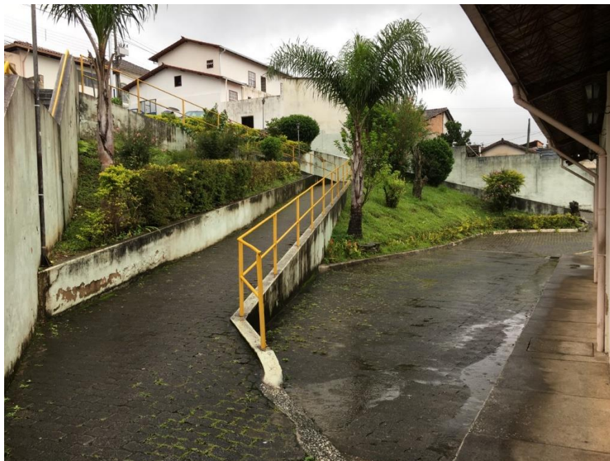
Figura 12: Vegetação ao redor da edificação Fonte: Acervo da autora, 2018
