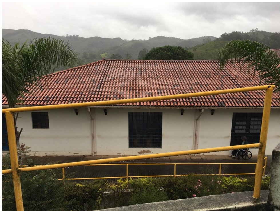
Figura 10: Paredes e telhado do Lar São Vicente de Paulo Fonte: Acervo da autora, 2019
