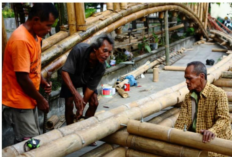
Figura 15: Arcos sendo montados no chão.
