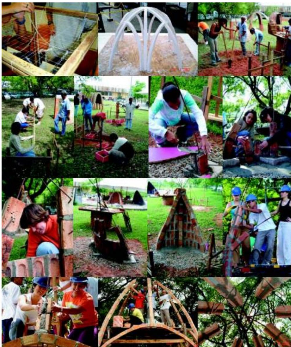
Figura 33: Execução de cúpula em arcos catenários. Referência: arquiteto Vitor Lotufo.
