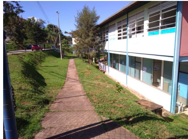
Figura 145: Vista a partir do acesso secundário dos três níveis de implantação. Fonte: Autor (2019).
