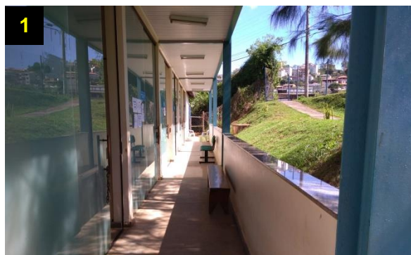
Figura 139: Vista geral da Circulação do bloco 1. Fonte: Autor (2019).
