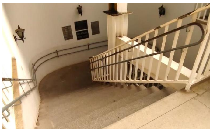
Figura 71: Acabamento recurvado ao final da escada. Fonte: Autor (2019).
