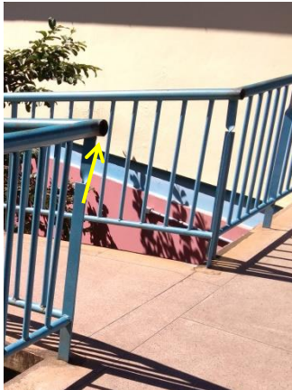
Figuras 155 e 156: Ausência de acabamento recurvado no guarda-corpo da rampa 2. Fonte: Autor (2019).
