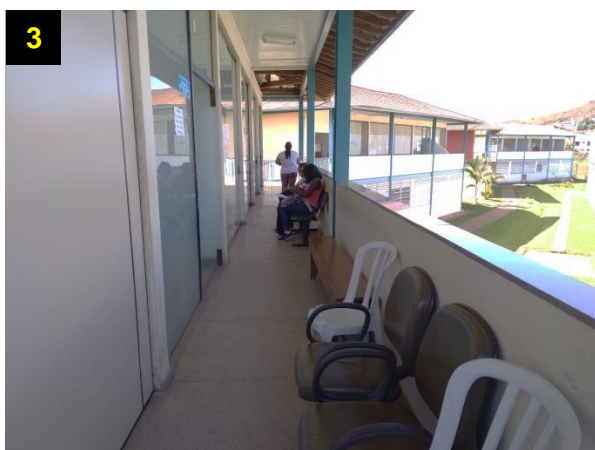
Figura 142: Obstáculos existentes na circulação do 2º Pavimento, bloco 1. Fonte: Autor (2019).
