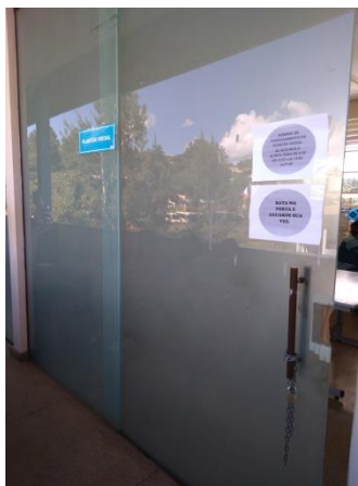
Figura 159: Puxador metálico existente nas portas de vidro. Fonte: Autor (2019).
