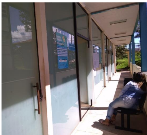
Figura 158: Portas de vidro de acesso às salas. Fonte: Autor (2019).
