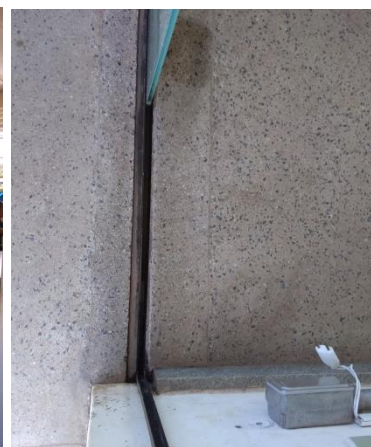
Figura 160: Fresta no piso devido ao trilho da porta de correr. Fonte: Autor (2019).
