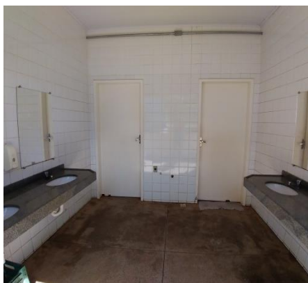
Figura 166: Ausência de identificação nas portas dos banheiros no 1º Pavimento. Fonte: Autor (2019)
