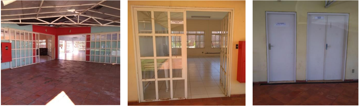
Figura 105, 106 e 107: Exemplos dos tipos de portas e sistemas de abertura encontrados. Fonte: Autor (2019).
