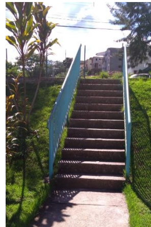
Figura 147: Vista geral da escada 1. Fonte: Autor (2019).
