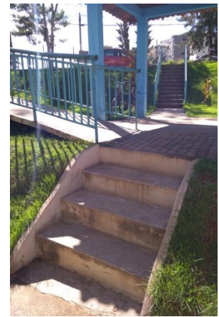
Figura 148: Vista geral da escada 2. Fonte: Autor (2019).
