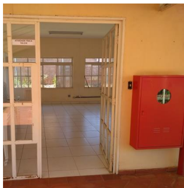
Figura 120, 121 e 122: Hidrantes prediais instalados próximo ao acesso principal, próximo à sala de Tai Chi Chuan e à Sala de Artesanato, respectivamente. Fonte: Autor (2019).
