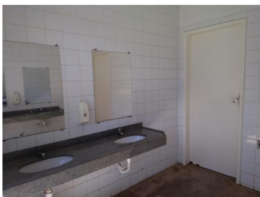
Figura 169: Bancada suspensa do lavatório no 1º Pavimento. Fonte: Autor (2019).
