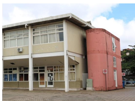
Figura 41: Ausência de calçada na fachada lateral direita. Fonte: Autor (2019)
