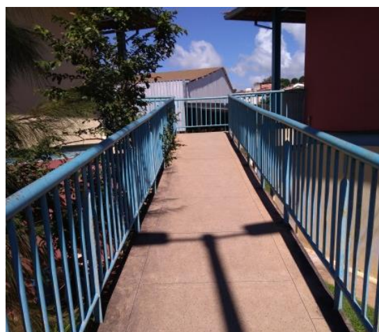
Figura 154: Vista do piso regular e ausência de corrimãos na rampa 2. Fonte: Autor (2019).
