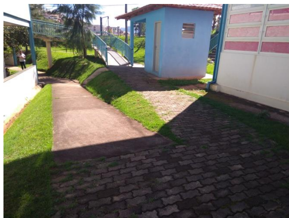
Figura 152: Ausência de corrimãos na rampa 1. Fonte: Autor (2019).
