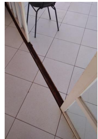
Figura 110: Fresta no piso para trilho da porta de correr. Fonte: Autor (2019).
