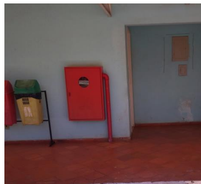
Figura 120, 121 e 122: Hidrantes prediais instalados próximo ao acesso principal, próximo à sala de Tai Chi Chuan e à Sala de Artesanato, respectivamente. Fonte: Autor (2019).
