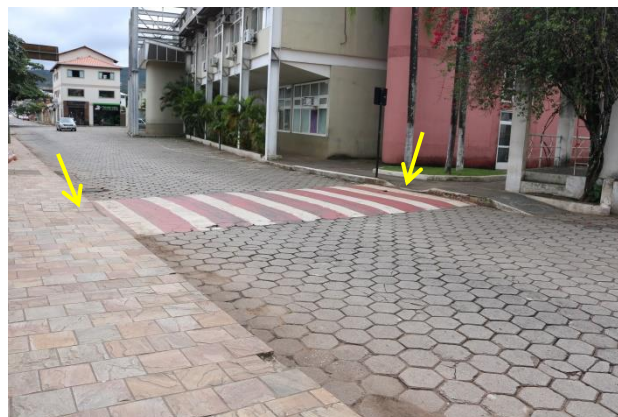
Figura 33: Faixa de pedestre que une o ponto à Praça JK, com rebaixamento de calçada nos dois lados da via. Fonte: Autor (2019).
