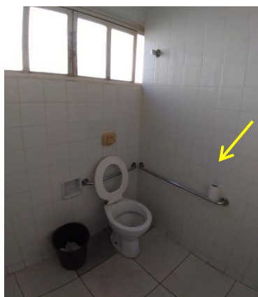
Figura 116: Ausência de barra de apoio vertical no banheiro da Oficina da Memória. Fonte: Autor (2019).
