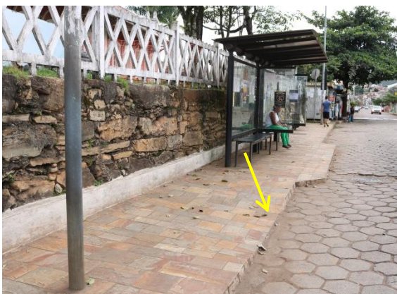
Figura 32: Rebaixamento de calçada próximo ao ponto B. Fonte: Autor (2019).
