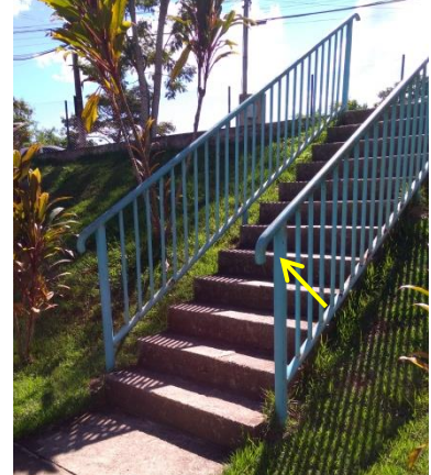
Figura 157: Falta de prolongamento no guarda-corpo da escada. Fonte: Autor (2019).
