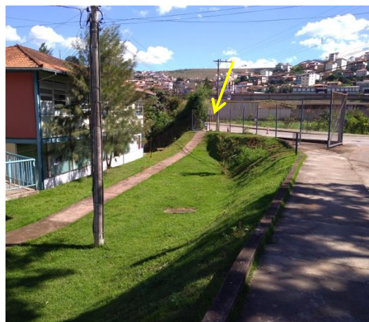
Figura 129: Desnível e distância entre os dois acessos, visto a partir da calçada do estacionamento. Fonte: Autor (2019).
