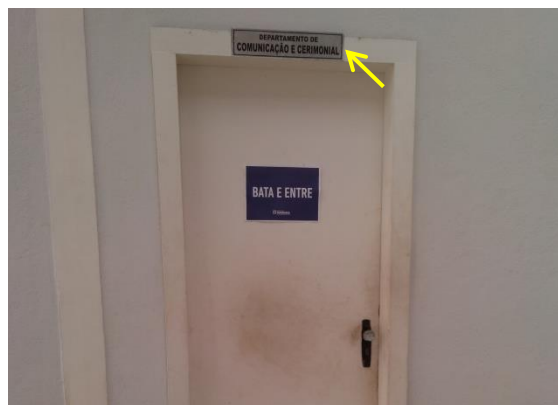
Figura 74: Placa de identificação e maçaneta tipo bola. Fonte: Autor (2019).
