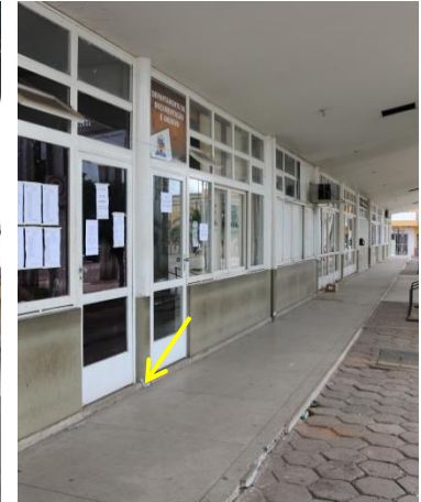
Figura 51: Vista do degrau de 5,5cm entre a calçada e os acessos. Fonte: Autor (2019)
