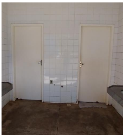
Figura 161: Portas prancheta com maçaneta alavanca nos banheiros. Fonte: Autor (2019)
