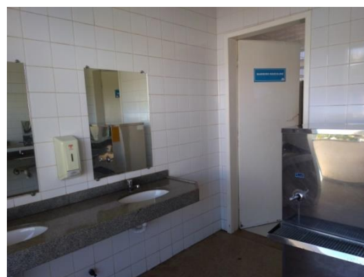
Figura 170: Acessórios e espelhos instalados junto ao lavatório no 2º Pavimento. Fonte: Autor (2019).
