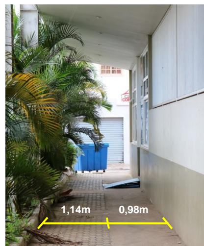
Figura 39: Vista da calçada posterior e rampa improvisada. Fonte: Autor (2019).
