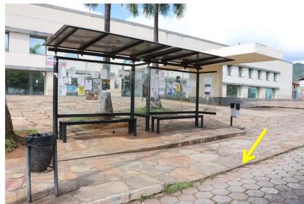
Figura 31: Vista geral do ponto e desnível entre a calçada e rua Fonte: Autor (2019).
