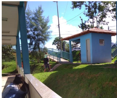
Figura 134: Desnível entre a Recepção e o Primeiro Pavimento. Fonte: Autor (2019).
