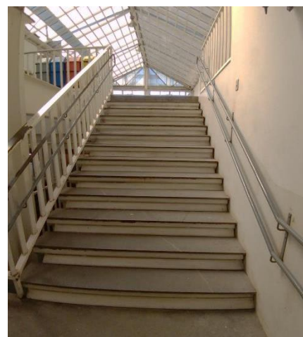
Figura 69: Vista do 2º lance da escada. Fonte: Autor (2019).
