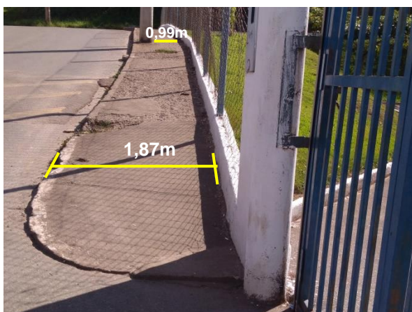
Figura 87: Condições da calçada do Recriavida. Fonte: Autor (2019).
