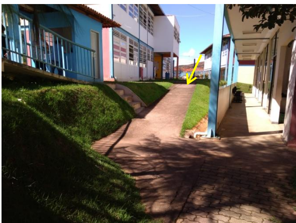
Figura 151: Vista geral da rampa 1. Fonte: Autor (2019).
