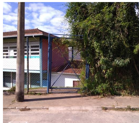
Figura 132: Vista do crescimento da vegetação no acesso secundário. Fonte: Autor (2019).
