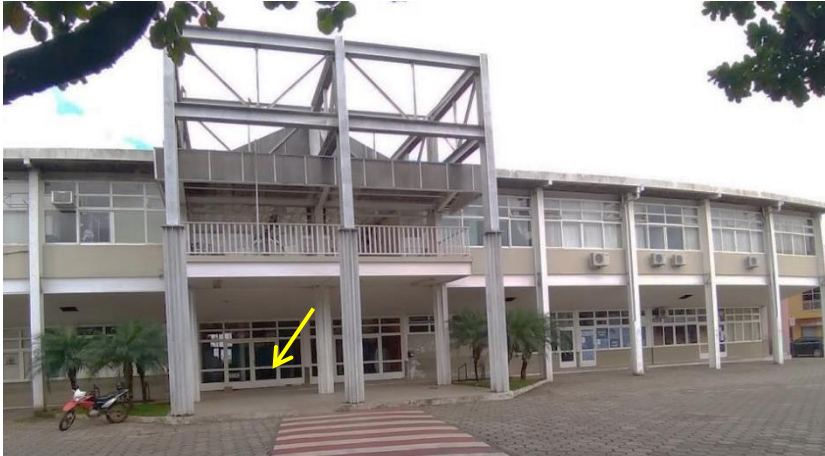
Figura 50: Vista do acesso principal à sede Prefeitura. Fonte: Autor (2019)
