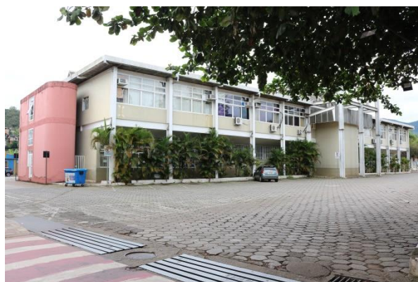
Figura 26: Vista da Fachada Posterior da Prefeitura. Fonte: Autor (2019).
