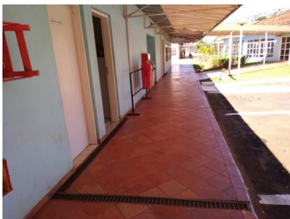
Figura 99: Presença de Grelhas na área de circulação. Fonte: Autor (2019).
