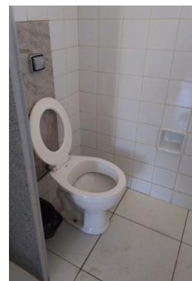
Figura 168: Ausência de barras de apoio e dimensão insuficiente nos boxes sanitários. Fonte: Autor (2019).
