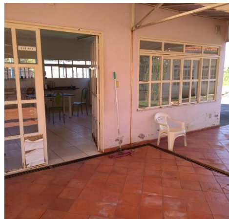
Figura 109: Grelhas em frente à porta da cozinha. Fonte: Autor (2019).
