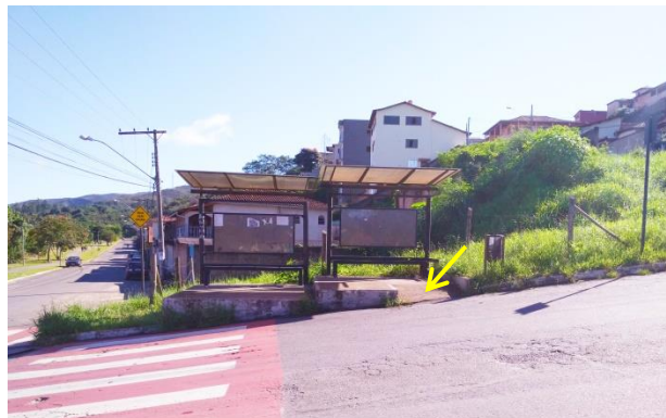
Figura 85: Ponto D e destaque para Rebaixamento fora da faixa de travessia. Fonte: Autor (2019).
