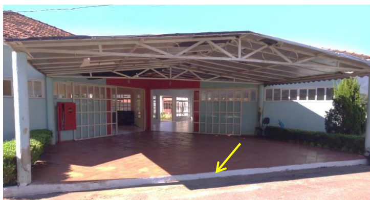
Figura 91: Desnível entre o asfalto e o acesso principal à edificação Fonte: Autor (2019).
