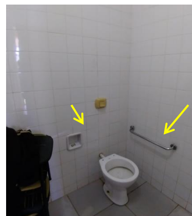
Figura 117: Ausência de barra horizontal e vertical no banheiro próximo à Fisioterapia. Fonte: Autor (2019).
