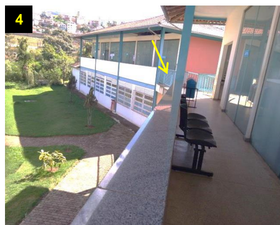
Figura 143: Vista geral da circulação com destaque para o guarda-corpo do patamar. Fonte: Autor (2019).
