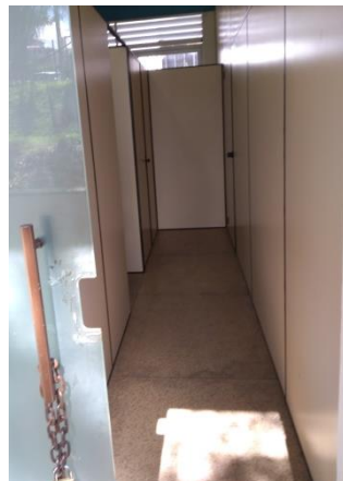
Figura 162: Portas divisórias com maçanetas do tipo bola. Fonte: Autor (2019)
