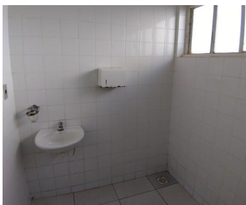
Figura 118 e 119: Ausência de barras de apoio próximas ao lavatório e acessórios fixados em altura elevada, fotos tiradas no banheiro masculino da Oficina da Memória e banheiro/depósito próximo à Fisioterapia. Fonte: Autor (2019).
