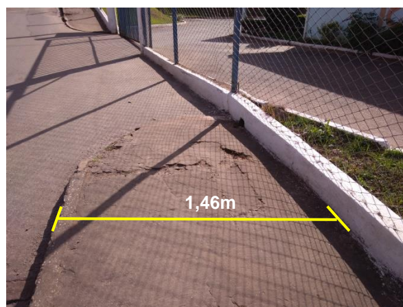
Figura 88: Falta de Rebaixamento no fim da calçada. Fonte: Autor (2019).
