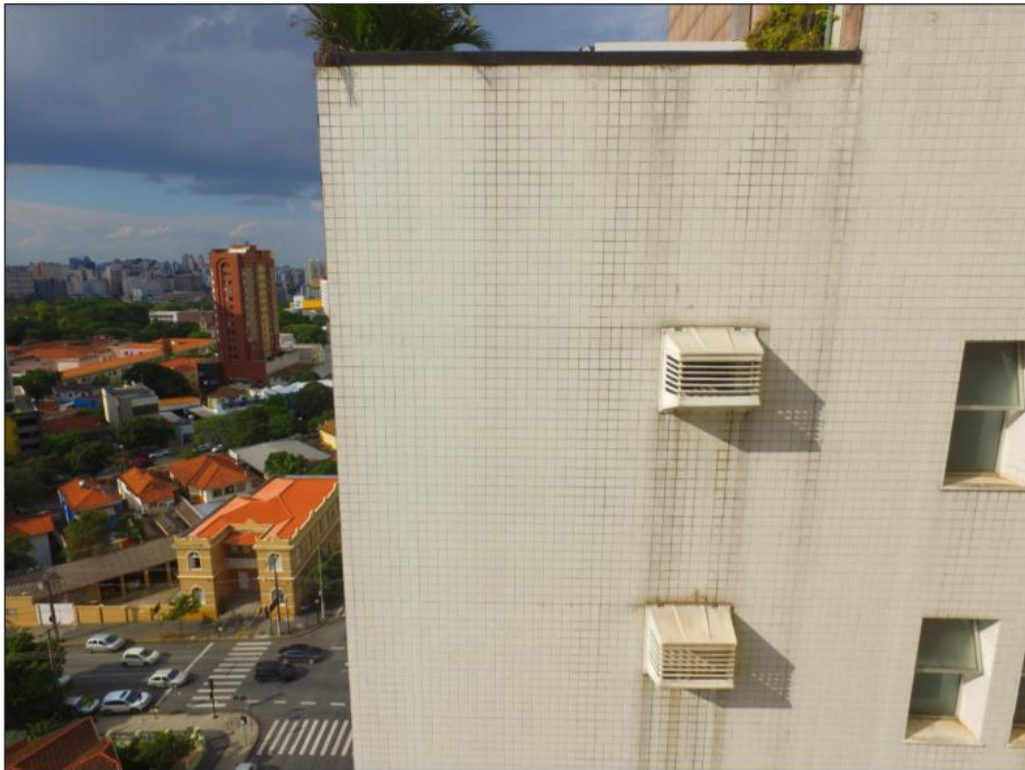
Figura 15 - Foto tirada por um drone durante uma inspeção predial (ASSIS, DRUMOND, et al. , 2017)
