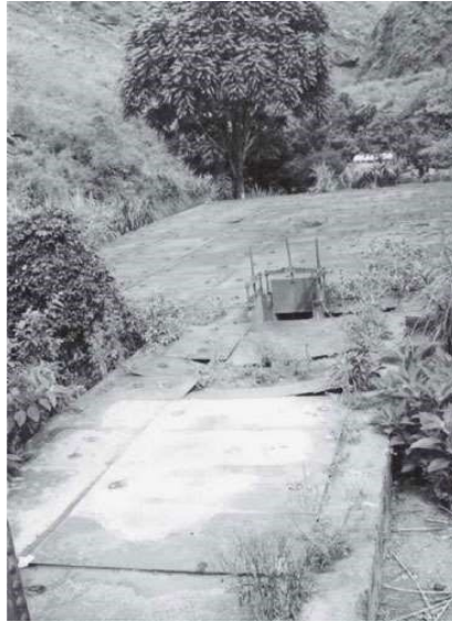
Figura 9- Tanque do Sistema de água e esgoto da Barra - OP/MG
