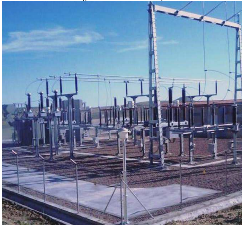
Figura 2.4 - Foto de subestação
