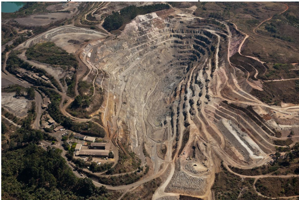
Figura 10: Cava da mina vista de sudeste para noroeste.
