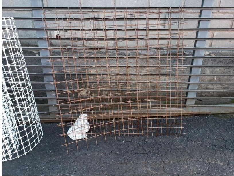
Figura 23 - Tela Soldada metálica
