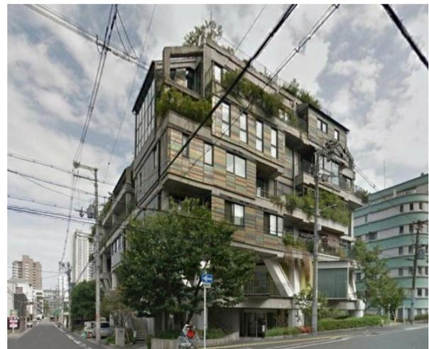
Figura 36: NEXT21, em Osaka; projetado originalmente por Habraken para abrigar a moradia de trabalhadores da Companhia de Gás de Osaka; os fechamentos de fachada assim como internos eram móveis e de fácil substituição pelo morador. Fonte: Moraes (2018)
