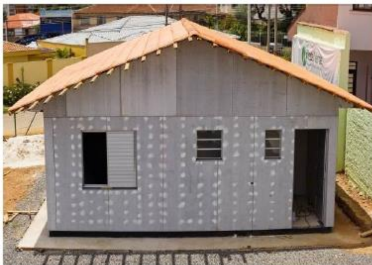
Figura 2.5 Casa montada (sem acabamento).
