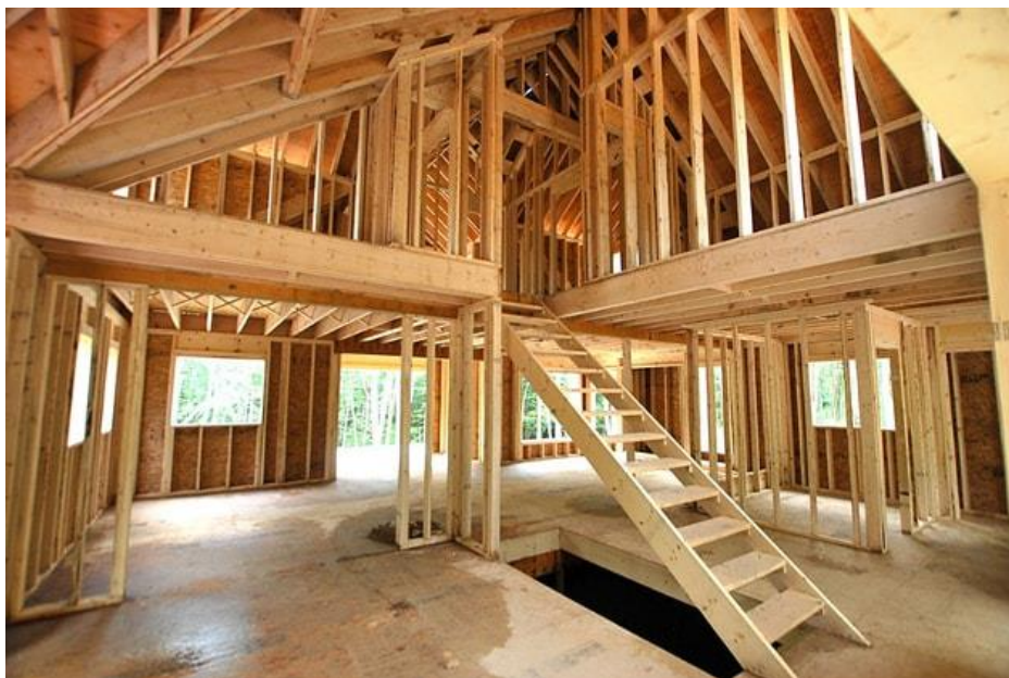
Figura 2.3 Construção em Wood Frame
