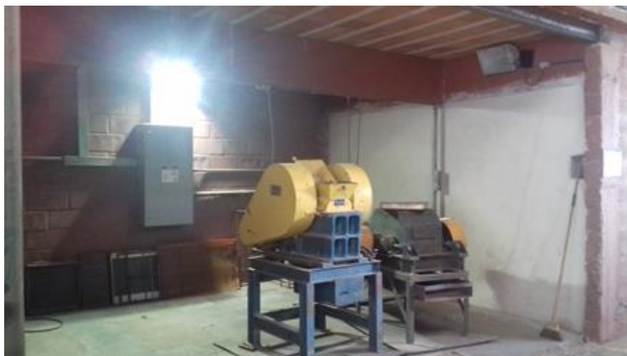
Figura 6 - Ambiente de Britagem
