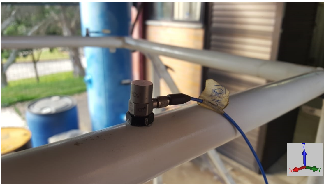
Figura 32: Acelerômetros fixados. Fonte: Autor.
