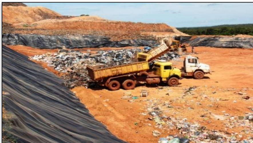
Figura 1.7 - Operação de um aterro sanitário 7
