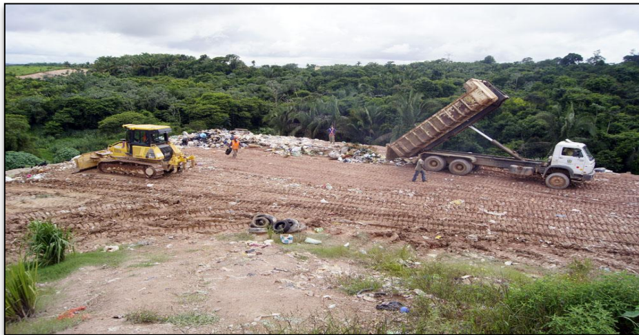
Figura 1.6 - Operação de um aterro controlado 6 Fonte: MARQUES (2019)
