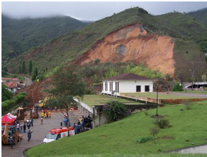
Figura 4.1 - Escorregamento ocorrido em 2012, em Ouro Preto, na encosta acima da rodoviária. Fonte: Prefeitura de Ouro Preto (2018).
