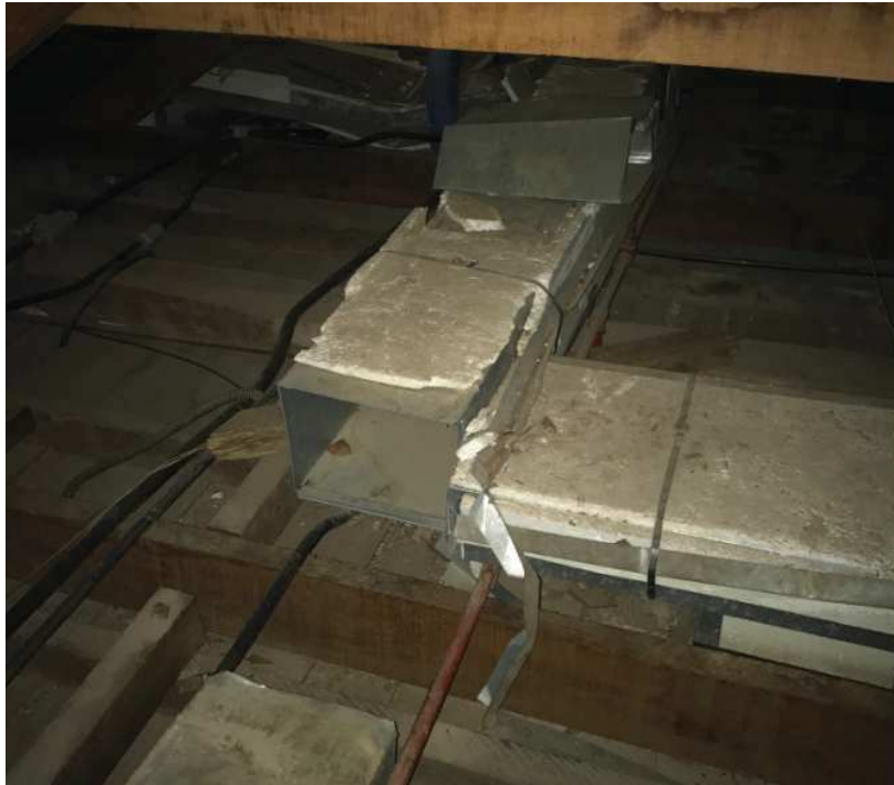
Figura 9: Situação dos dutos do sistema de insuflamento Fonte: Pesquisa Direta (2018)
