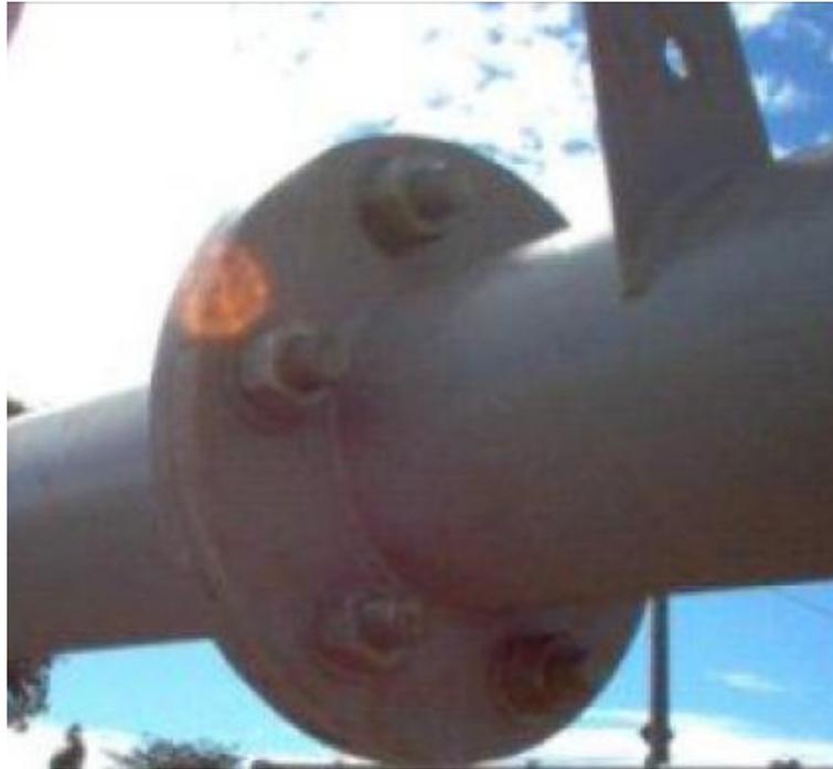
**FIGURA 1.3:** Detalhe daLigação Flangeada
