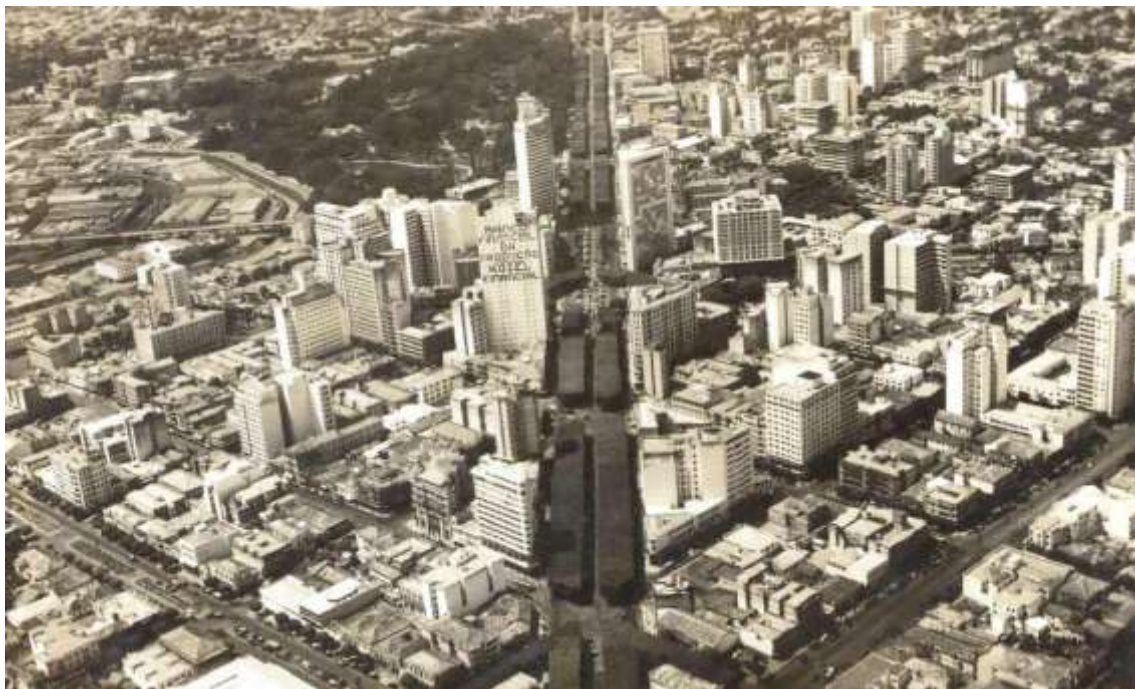
Figura 8 - Crescimento na cidade de Belo Horizonte representado pela abertura de várias vias e construção de prédios, principalmente na região central da cidade. Fonte: APM. 10
