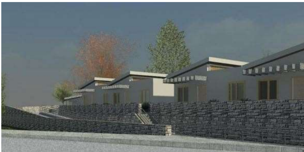
Figura 13: Fachada frontal das geminadas (Reciclos, 2013)
