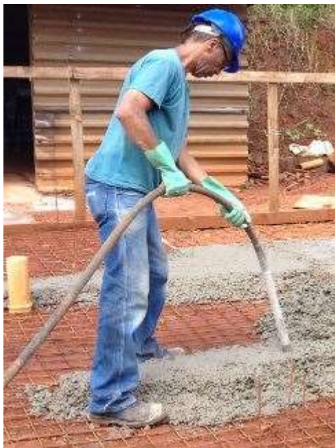
Figura 32: Vibração do concreto
