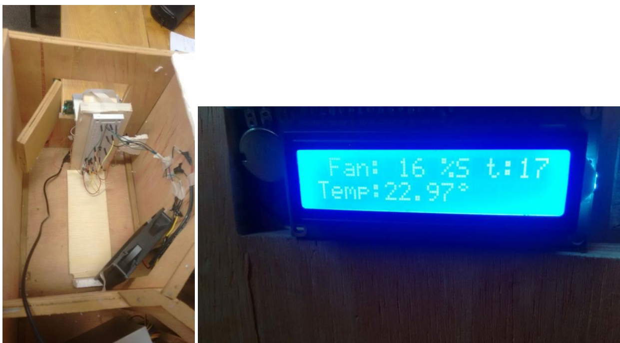
Figura 12: Sistema de Controle de Temperatura instalado no protótipo e tela de apresentação de dados
