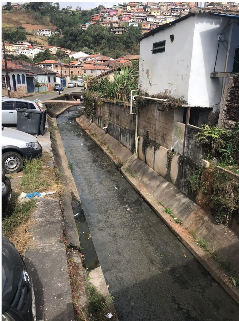
Figura 10: Lançamento de esgoto diretamente nos cursos d'água
