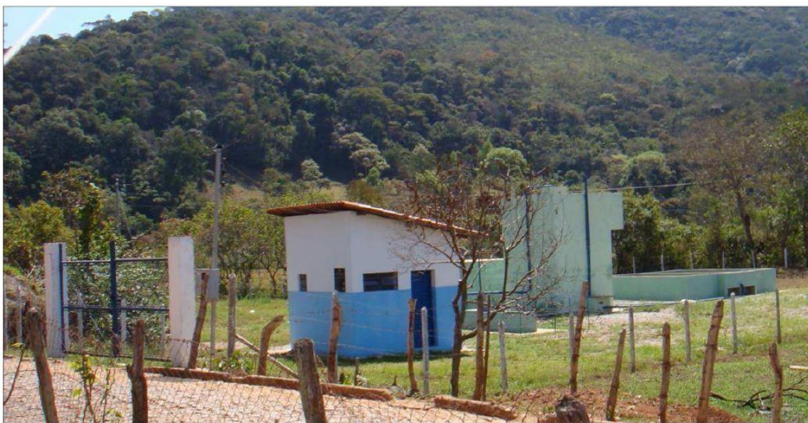
Figura 12: ETE São Bartolomeu
