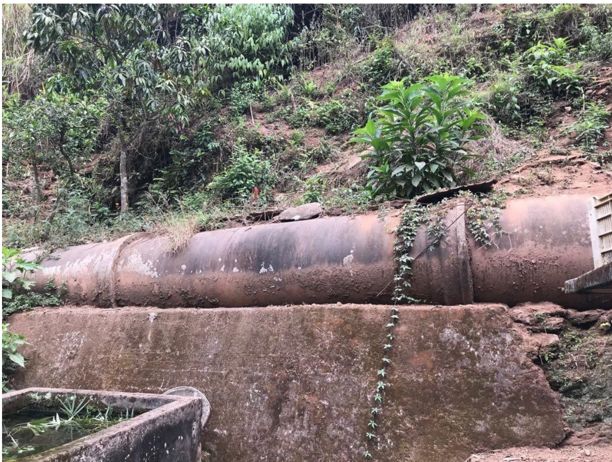
Figura 7: Tubulação principal do século XIX
