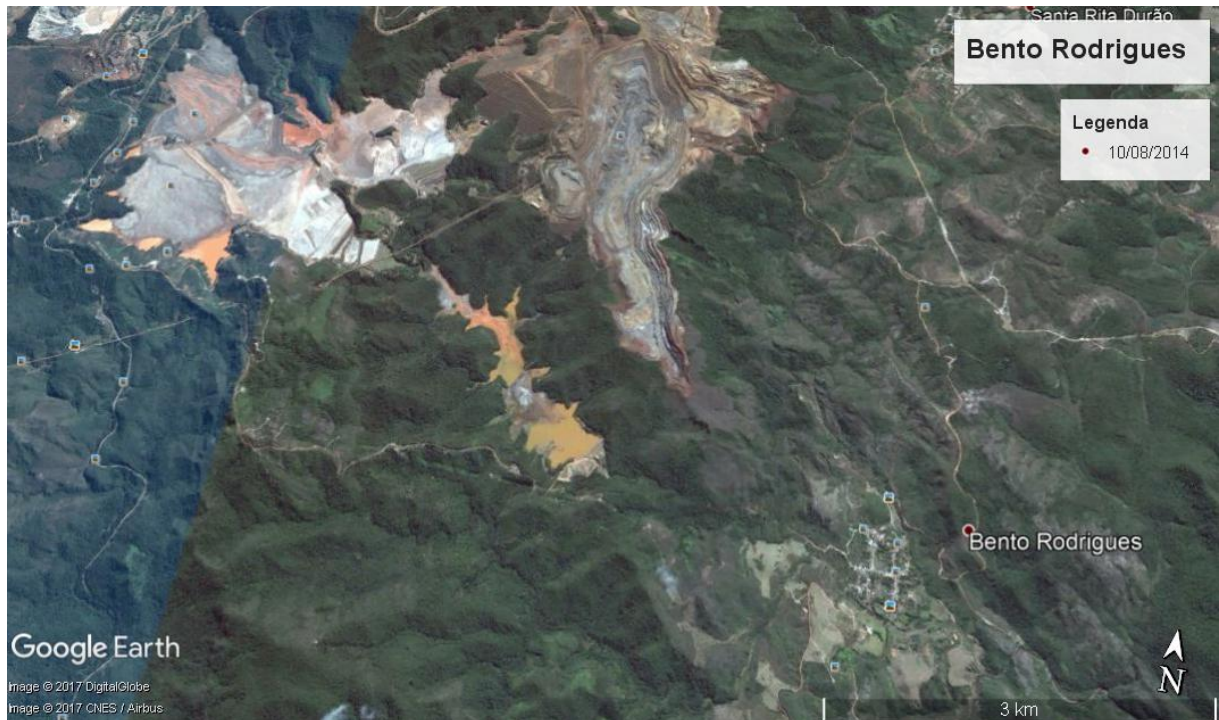
Figura 1: Vista panorâmica de Bento Rodrigues. Disponível no Google Earth.
