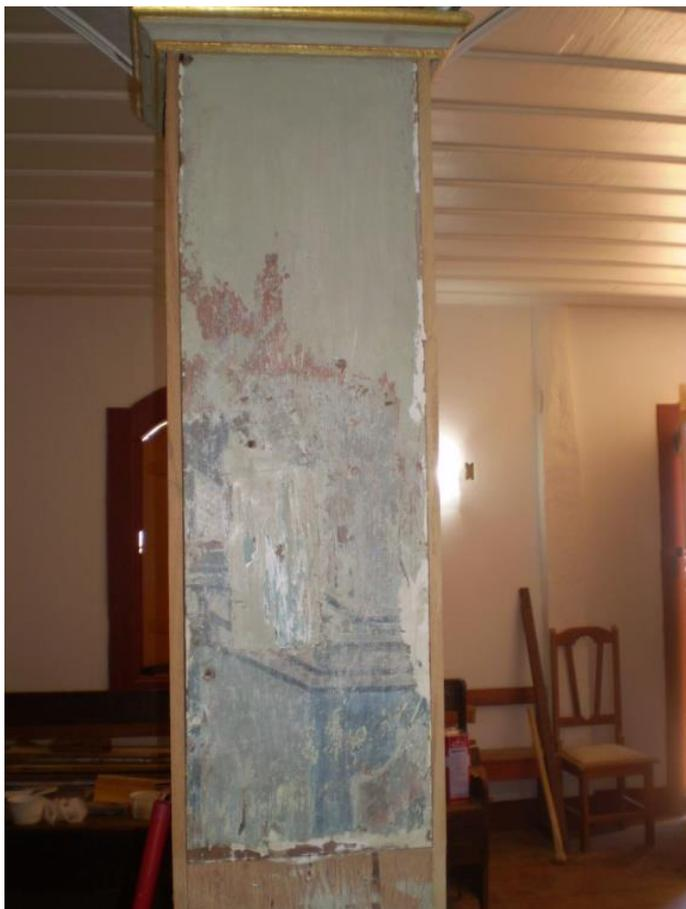
**FIG 33** – Detalhe da pilastra de sustentação sem camadas de repintura,
