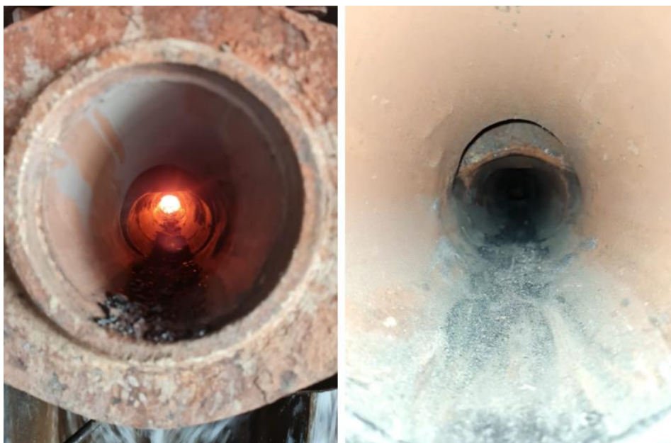
Figura 5-1 - Algaravizes antes e após vedação
