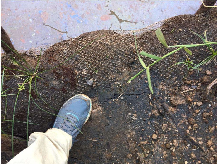
Figura 5.8 – Geogrelha instalada na borda do rio do Carmo, material consegue ultrapassar a proteção e deposita no rio, nota-se a quantidade de material acumulado na superfície do rio.
