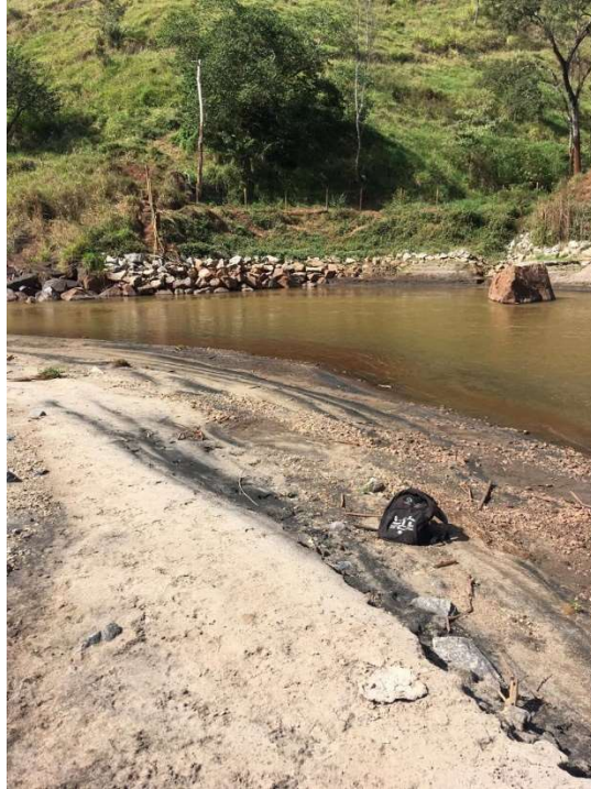
Figura 5.5 - Blocos realocados na calha do Rio Gualaxo do Norte provenientes do enrocamento utilizado para conter a erosão da margem externa
