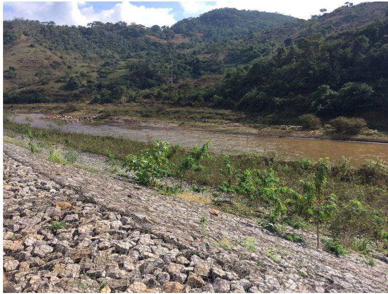
Figura 6.4 – Foto evidenciando o retaludamento do Rio do Carmo, Barra Longa – MG
