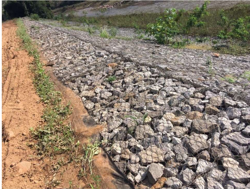
Figura 5.4- Trabalho realizado no retaludamento e enrocamento do Rio do Carmo, nota-se ao fundo blocos adentrando às margens do rio
