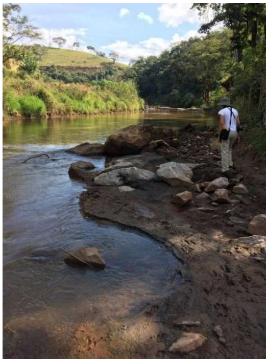
Figura 5.6 -Foto evidenciando os blocos soltos advindos do enrocamento realizado no Rio Gualaxo do Norte
