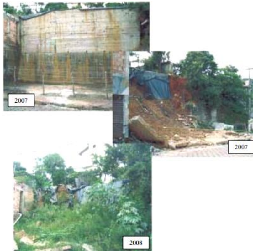
Figura 12 - Exemplo de medida estrutural inadequada, Rua René Gianetti, Ouro Preto (FONTES,2011).
