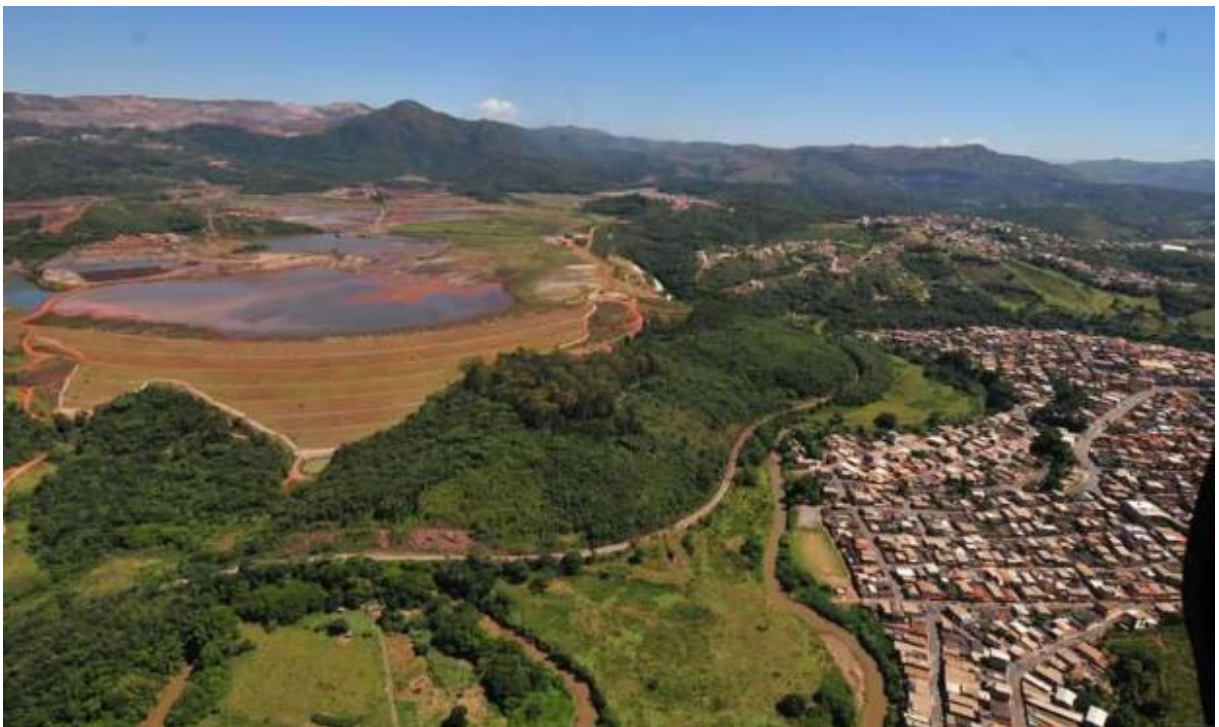
Figura 3 - Exemplo de Barragem de Rejeito de Minério de Ferro localizada no município de Congonhas – MG (LISBOA,2019).
