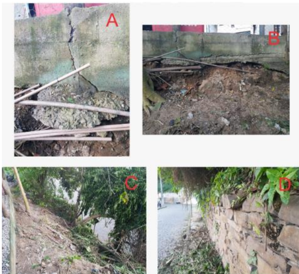
Figura 24-Patologias encontradas nas contenções existentes na encosta: (A) Trinca na viga Baldrame, possivelmente causada pela erosão, (B) Erosão do solo, (C) Vegetação com o caule retorcido (D) Desprendimento da Pedra de Mão do Muro existente.
