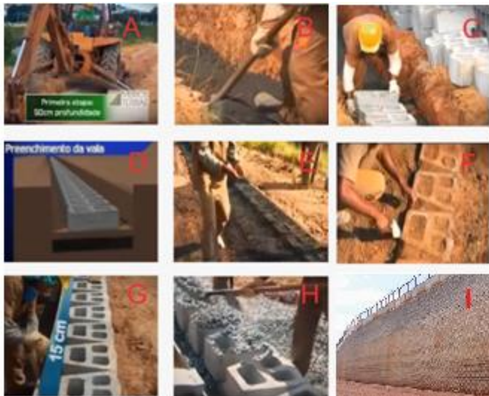
Figura 22- Procedimentos de execução de um Muro Terrae: (A) Abertura da vala; (B) Camada de concreto; (C) Colocação dos blocos W; (D) Preenchimento da vala com solo; (E) Nivelamento e limpeza dos blocos W; (F) Colocação do material geossintético; (G) Afastamento para a drenagem; (H) Preenchimento dos blocos W com brita e (I) Muro Terrae com cobertura vegetal (Huesker, 2019).
