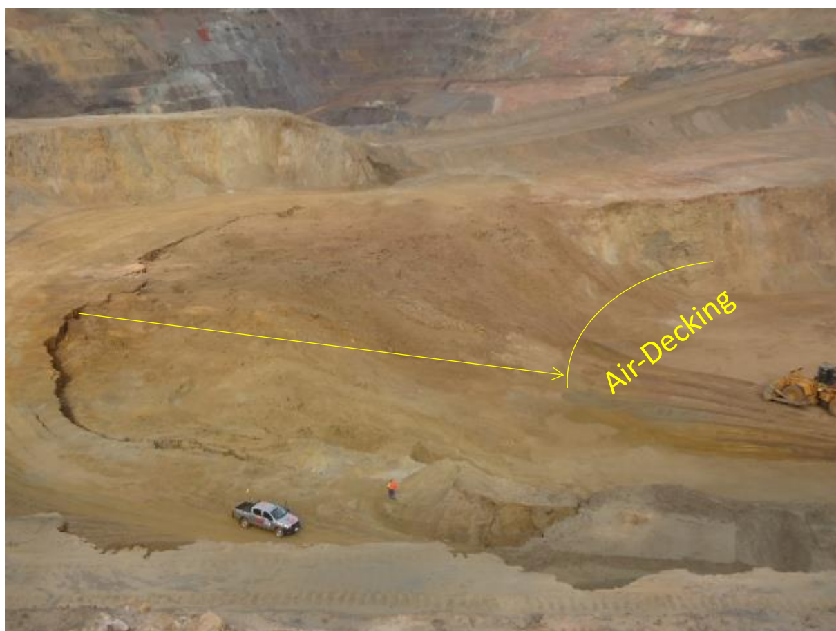
Figura 12: Registro fotográfico após o desmonte.
