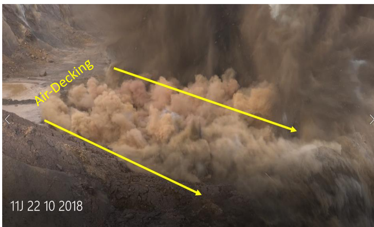
Figura 14: Captura de vídeo do desmonte executado na 11J.
