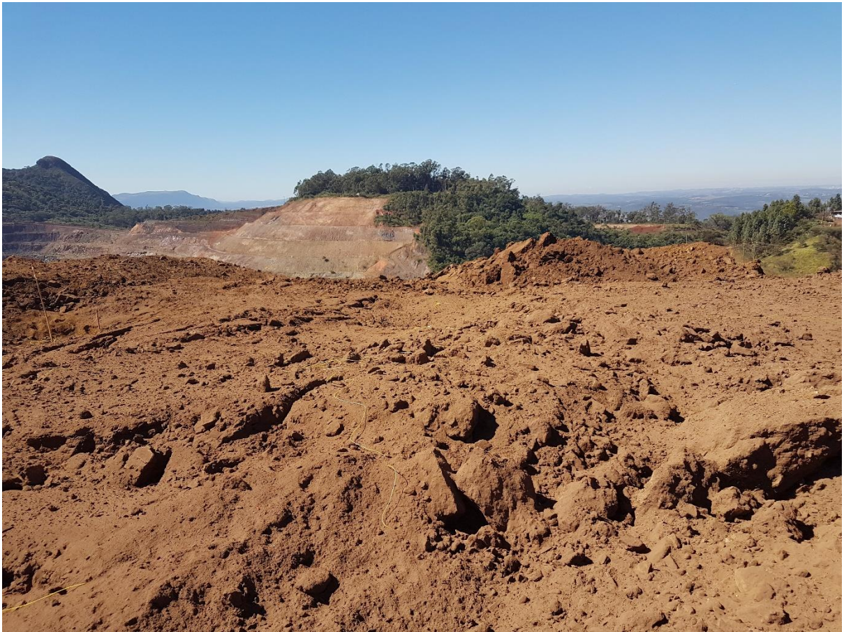
Figura 9: Fotografia após desmonte 6L.
