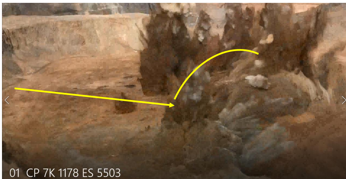
Figura 11: Captura de vídeo do desmonte executado na 7K.
